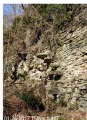
01-26-2017 TSlysch 117 Caratteristica scala con gradini incastrati nel muro di "pastino".
