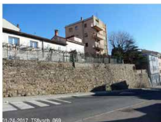
01-24-2017 TSflysch_069 Muro contenimento in blocchi di arenaria (Gretta). Salita m.te di Gretta.
