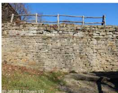
01-26-2017 TSlysch 112 Muro in arenaria a secco di "pastino" con tipica recinzione in legno.
