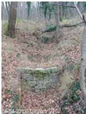
01-04-2017 TSlysch 270 Parco del Farneto-Cacciatore, "briglia" in arenaria lungo gli affluenti del Torr. Farneto.
