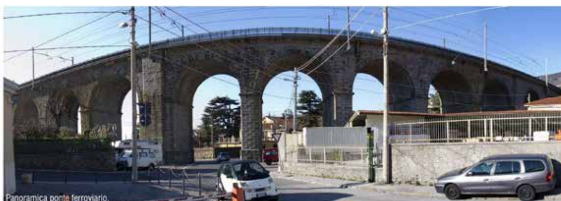
Panoramica ponte ferroviario. Viadotto in pietra arenaria, uno dei più vecchi d'Europa (1857).
